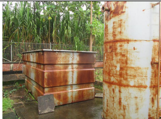
Foto 8. Unidades de floculación y filtración con evidencia de deterioró producto de la exposición a la intemperie.
