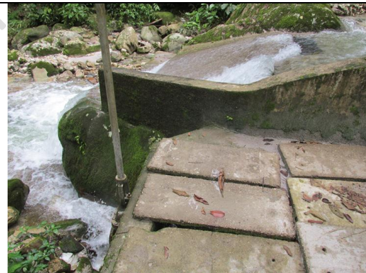
Fotos 13 y 14. Bocatoma sobre la quebrada Caño Blanco consistente en una rejilla de fondo posicionada sobre una presa derivadora con tanque desarenador en el costado izquierdo de la estructura. Posicionada sobre los 774 msnm.
