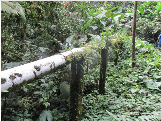
Foto 17. Paso elevado de la conducción apoyada sobre columnas de concreto.
