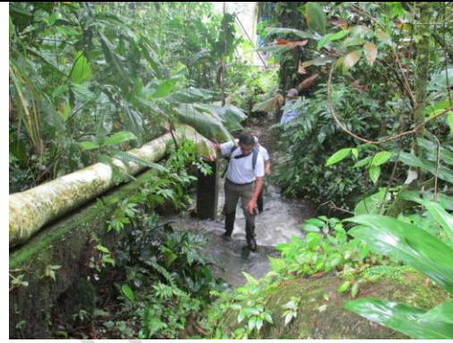
Foto 43. Paso elevado de la línea de conducción a través del lecho de una quebrada afluente al río Acacías.
