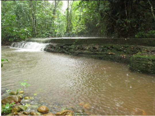
Fotos 1 y 2. Bocatoma actual del acueducto Las Camelias consistente en una tubería con coladera con control de niveles mediante presa derivadora.
