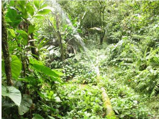
Fotos 15 y 16. Tubería de conducción posicionada sobre la superficie del suelo. Puede apreciarse el buen estado de conservación de la cobertura vegetal así como el alivio de presión en la tubería.
