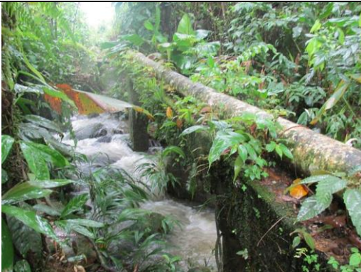
Foto 44. Paso elevado de la línea de conducción a través del lecho de una quebrada afluente al río Acacías.
