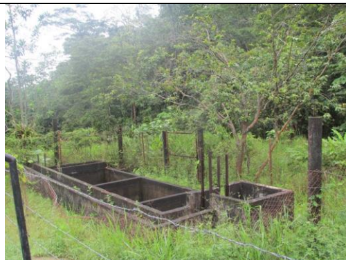
Foto 35. Antiguo desarenador y sedimentador de Acua 7.
