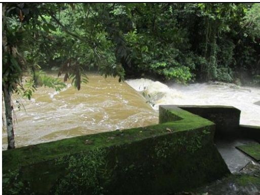
Fotos 30 y 31. Bocatoma del distrito de riego Asojuania, consistente en una presa derivadora con rejilla de fondo.
