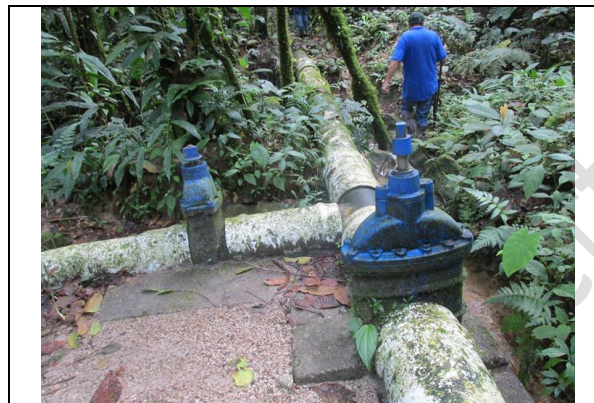
Foto 23. Válvulas para manejo de by-pass y control de flujo hacia tanques sedimentadores.
