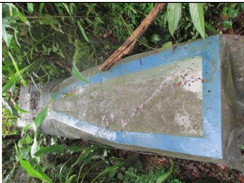
Foto 34. Canaleta Parshall para aforo de caudales captados hacia la PTAP.
