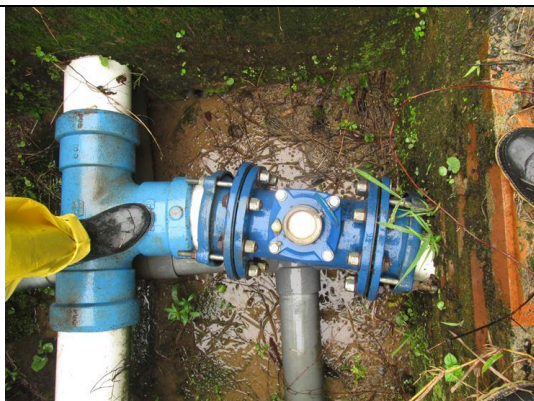
Foto 5. Macromedidor instalado en la entrada a la planta de tratamiento.
