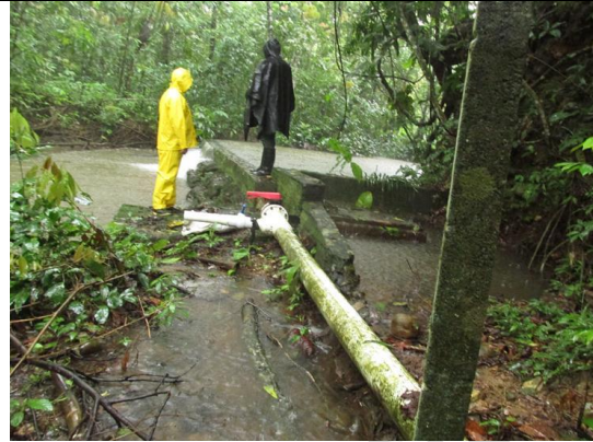
Fotos 1 y 2. Bocatoma actual del acueducto Las Camelias consistente en una tubería con coladera con control de niveles mediante presa derivadora.
