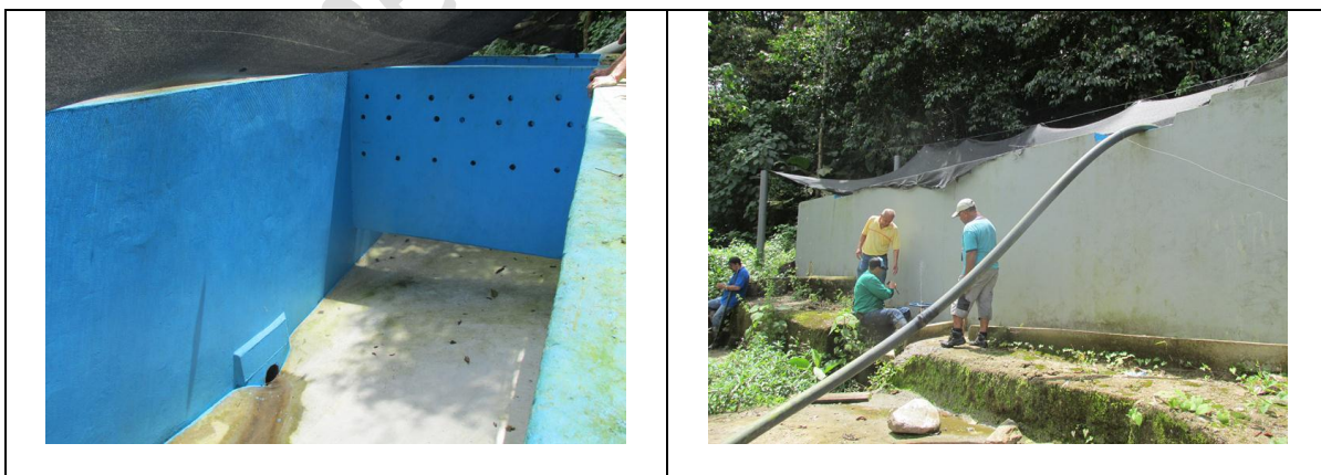
Fotos 24 y 25. Tanque Sardinata. Localizado sobre los 678 msnm en la margen izquierda del río Sardinata. Hacia este tanque se deriva agua para complementar el caudal de Caño Blanco en los periodos de estiaje.
