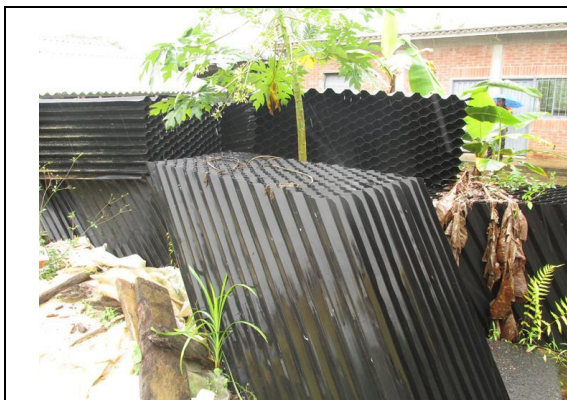
Foto 9. Módulos internos del floculador sin ser instalados y acopiados en el patio de la PTAP.
