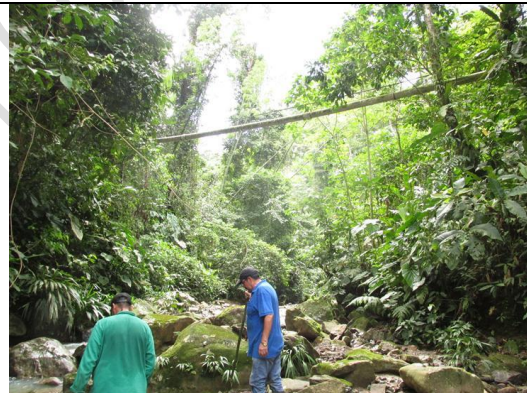
Foto 18. Paso elevado de la conducción sobre el lecho de una quebrada. La tubería es soportada mediante un cable anclado a los extremos del terreno.
