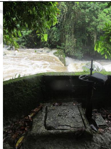
Fotos 28 y 29. Bocatoma del acueducto veredal Acua 7, consistente en una presa derivadora con rejilla de fondo.
