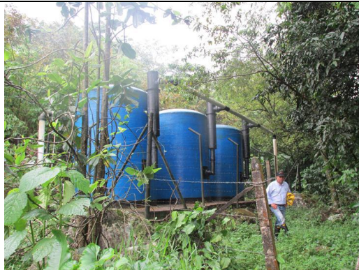
Foto 41. PTAP completamente instalada, incluyendo floculador, filtros y cloración. Operó por un período de 2 meses antes de su colmatación.
