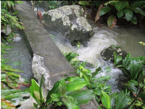
Foto 42. Estructura de concreto para protección de la línea de conducción a su paso por un caño.
