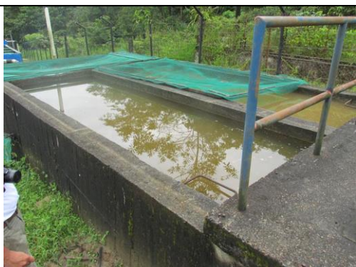
Foto 36. Tanques desarenadores actualmente en operación. Constituyen el único tratamiento aplicado al agua antes de ser entregada a los usuarios.
