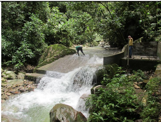
Fotos 13 y 14. Bocatoma sobre la quebrada Caño Blanco consistente en una rejilla de fondo posicionada sobre una presa derivadora con tanque desarenador en el costado izquierdo de la estructura. Posicionada sobre los 774 msnm.
