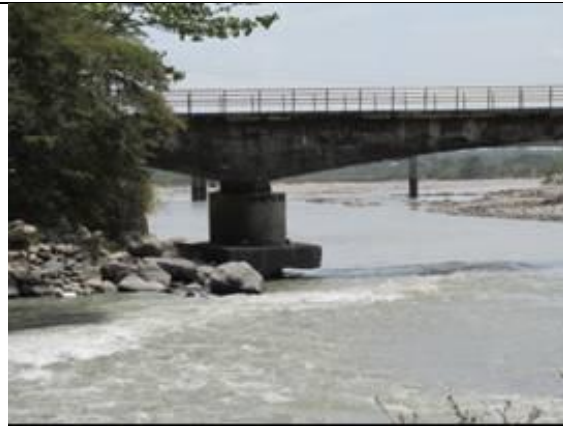
Foto 2. Socavación de una de las pilas que soportan el antiguo puente de la vía Villavicencio – Acacías.
