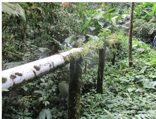
Foto 8. Paso elevado de la conducción apoyada sobre columnas de concreto.
