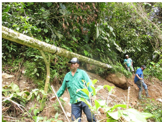
Foto 9. Proceso activo de remoción en masa con deslizamiento de materiales pétreos y árboles que ponen en riesgo la tubería y continuidad del servicio.
