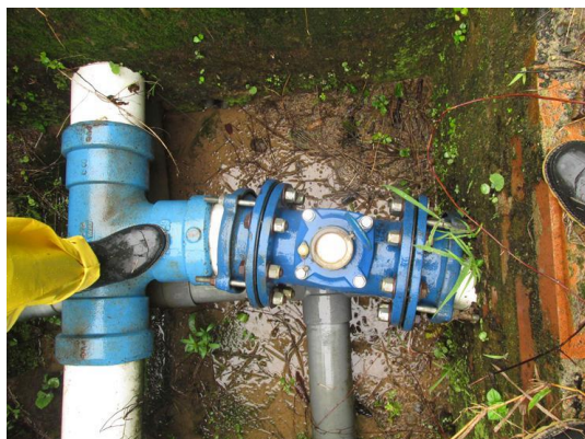
Foto 3. Macromedidor instalado en la entrada a la planta de tratamiento.
