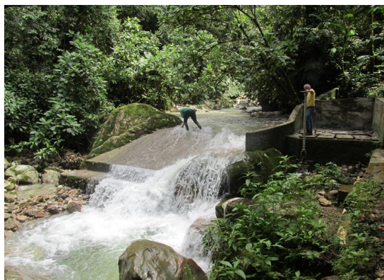
Foto 7. Bocatoma sobre la quebrada Caño Blanco consistente en una rejilla de fondo posicionada sobre una presa derivadora con tanque desarenador en el costado izquierdo de la estructura. Posicionada sobre los 774 msnm.
