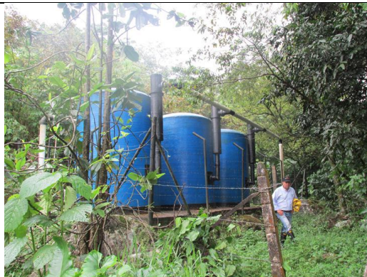
Foto 16. PTAP completamente instalada, incluyendo floculador, filtros y cloración. Operó por un período de 2 meses antes de su colmatación.
