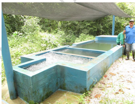
Foto 10. Tanque Caño Blanco posicionado sobre los 766 msnm. Dimensiones de 6,0 m de longitud, 2,5 m de ancho y 2,0 m de profundidad.
