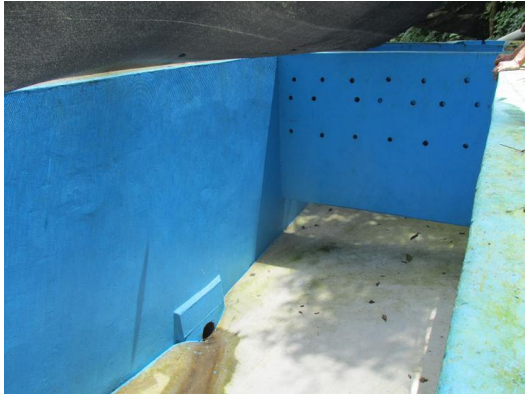
Foto 11. Tanque desarenador Sardinata. Localizado sobre los 678 msnm en la margen izquierda del río Sardinata.
