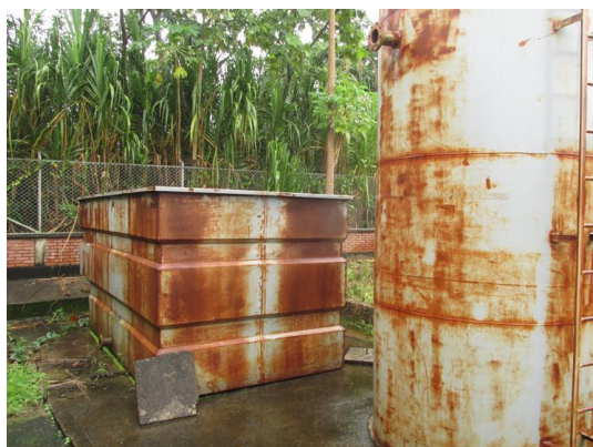
Foto 5. Unidades de floculación y filtración con evidencia de deterioro producto de la exposición a la intemperie.
