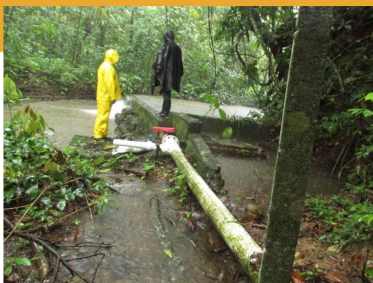
Figura 1 Bocatoma actual del acueducto Las Camelias consistente en una tubería con coladera con control de niveles mediante presa derivadora.
