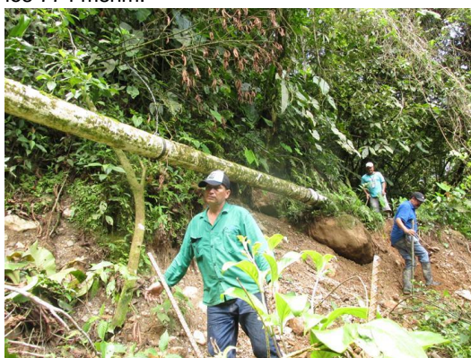
Foto 9. Proceso activo de remoción en masa con deslizamiento de materiales pétreos y árboles que ponen en riesgo la tubería y continuidad del servicio.
