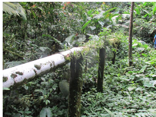
Foto 8. Paso elevado de la conducción apoyada sobre columnas de concreto.
