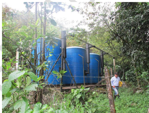
Foto 16. PTAP completamente instalada, incluyendo floculador, filtros y cloración. Operó por un periodo de 2 meses antes de su colmatación.
