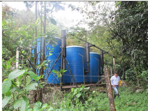
Foto 14. Tanques desarenadores actualmente en operación. Constituyen el único tratamiento aplicado al agua antes de ser entregada a los usuarios.
