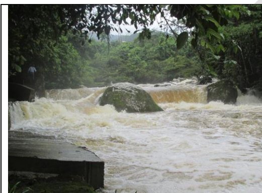
Foto 13. Bocatoma del acueducto veredal Acua 7, consistente en una presa derivadora con rejilla de fondo.
