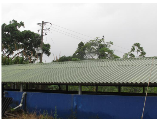
Foto 4. Cuatro tanques sedimentadores de 7,0 m de longitud, 4,0 m de ancho y 2,5 m de profundidad.
