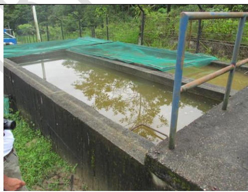
Foto 14. Tanques desarenadores actualmente en operación. Constituyen el único tratamiento aplicado al agua antes de ser entregada a los usuarios.
