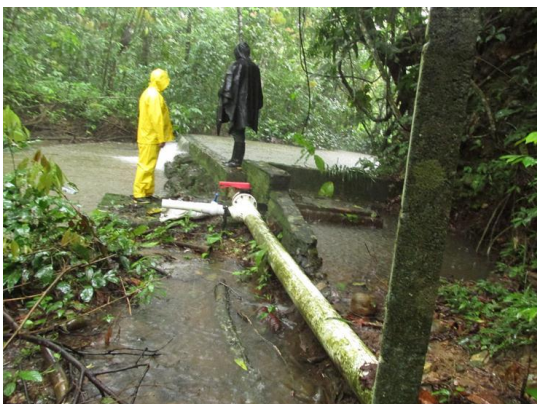
Foto 1. Bocatoma actual del acueducto Las Camelias consistente en una tubería con coladera con control de niveles mediante presa derivadora.
