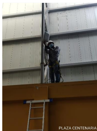
Proceso instalación de Equipos de puntos de acceso a Wifi en la Plaza centenaria.
