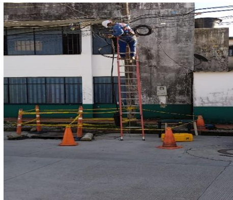
Proceso de Instalación de Fibra óptica Veinte de Julio
