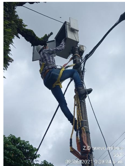
Adecuación de cableado antena Echo 5D en nodo Lilia Castro de parrado.
