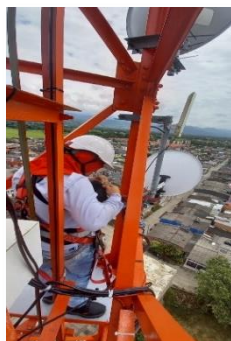
Adecuación de cableado antena Echo 5D en nodo Lilia Castro de parrado.
