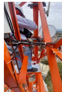
Adecuación de cableado antena Echo 5D en nodo Lilia Castro de parrado.
