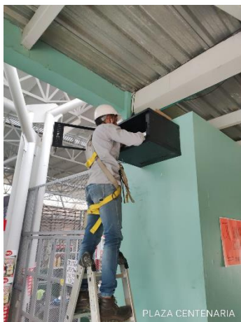
Proceso instalación de Equipos de puntos de acceso a Wifi en la Plaza centenaria.
