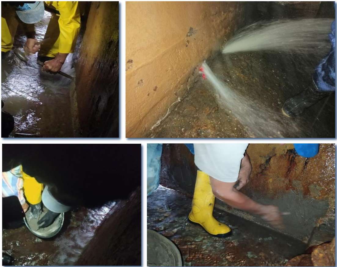
Obras de rehabilitación de estructuras con filtraciones
