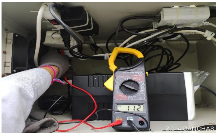
Adecuación eléctrica e Instalación de protector de voltaje Zona digital 4 canchas.
